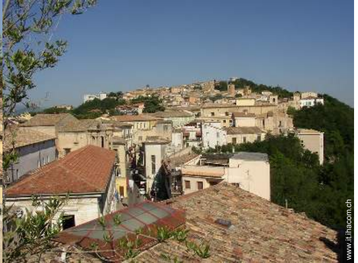
vista dalla terrazza sul tetto
