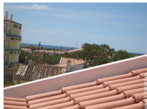
vista dalla terrazza sul tetto
