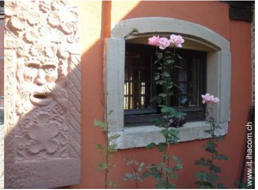
vista dal patio
