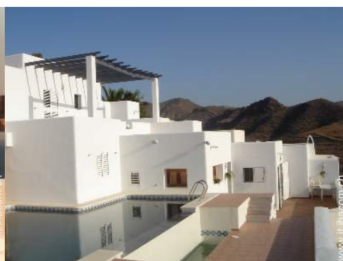
Piscina a sfioro
