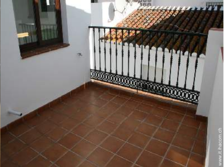
vista dalla terrazza sul tetto
