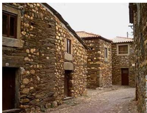
vista sul villaggio
