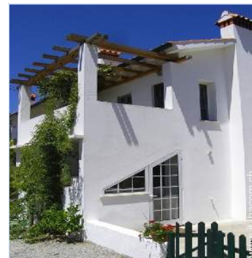
terrazzo sul tetto
