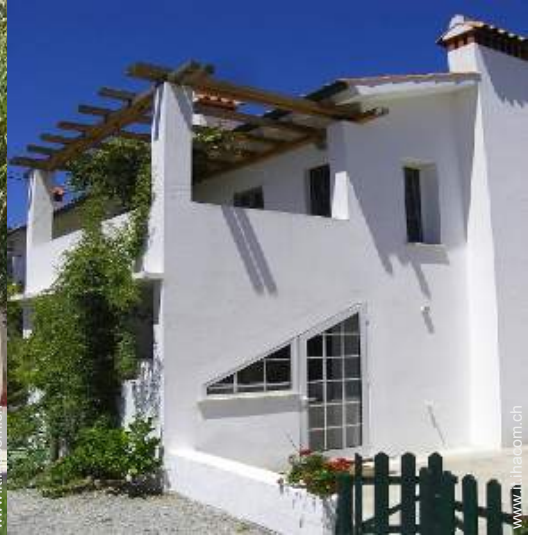
terrazzo sul tetto
