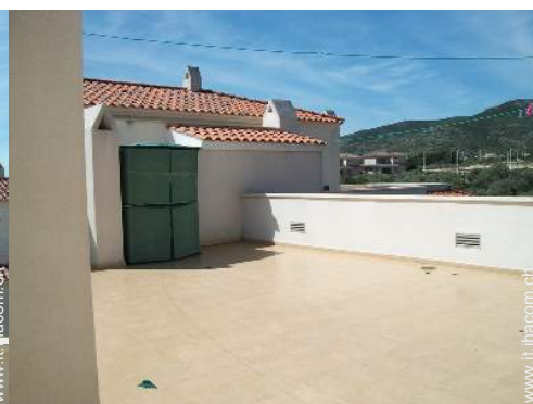
vista dalla terrazza sul tetto
