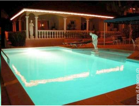
sistema di illuminazione
