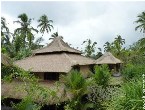
vista dalla terrazza sul tetto
