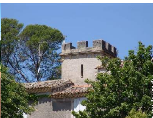
Antico Priorato di Lusso
