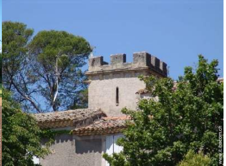
Antico Priorato di Lusso
