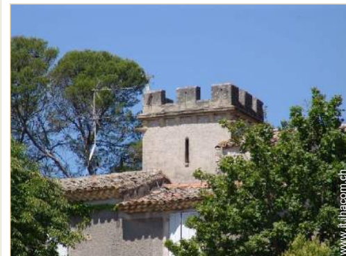
Antico Priorato di Lusso
