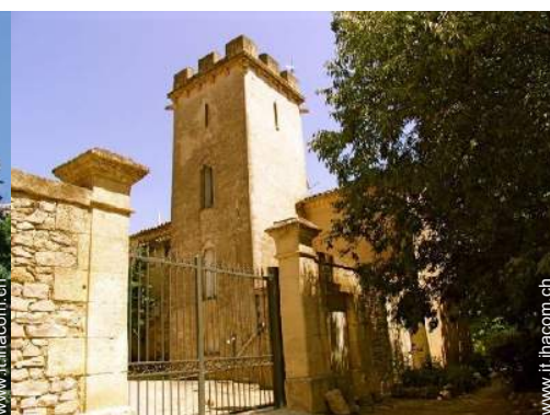
Antico Priorato di Lusso
