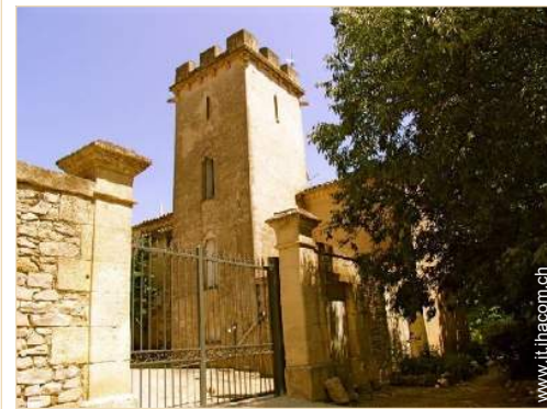
Antico Priorato di Lusso
