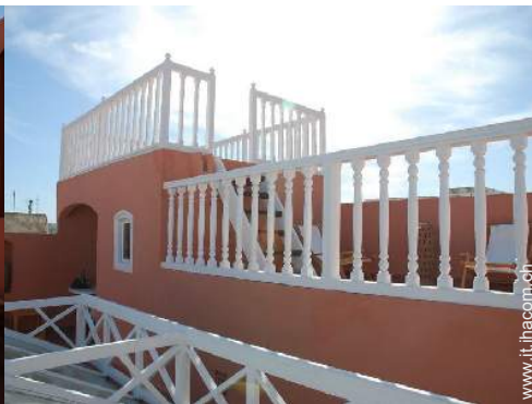
vista dalla terrazza sul tetto
