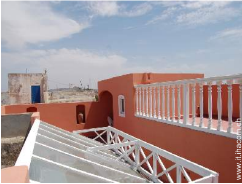
vista dalla terrazza sul tetto
