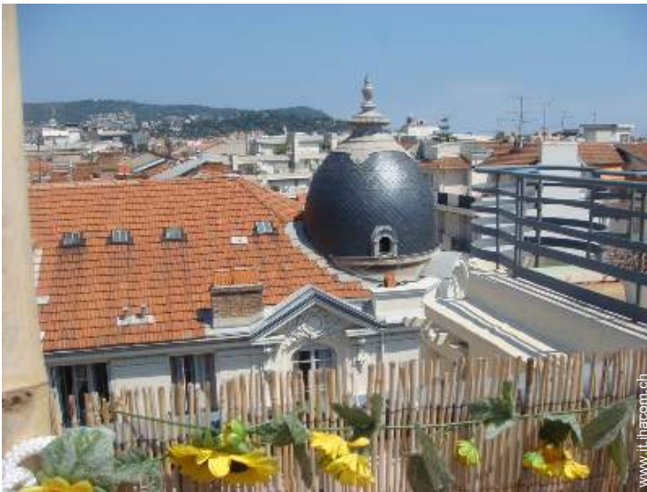
vista dalla terrazza sul tetto
