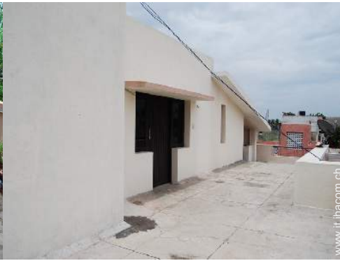
terrazzo sul tetto
