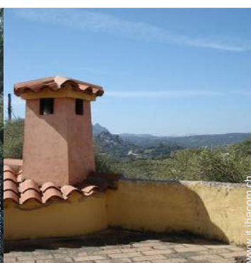
vista dalla terrazza sul tetto
