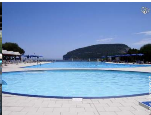
Piscina con acqua di mare
