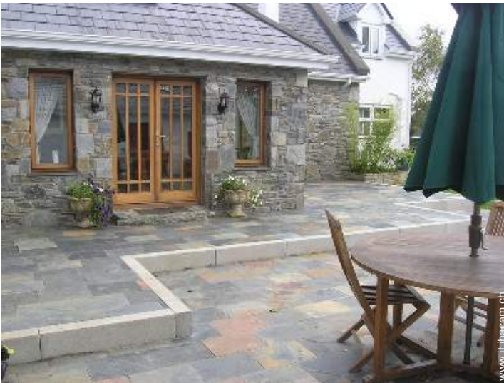
vista dal patio
